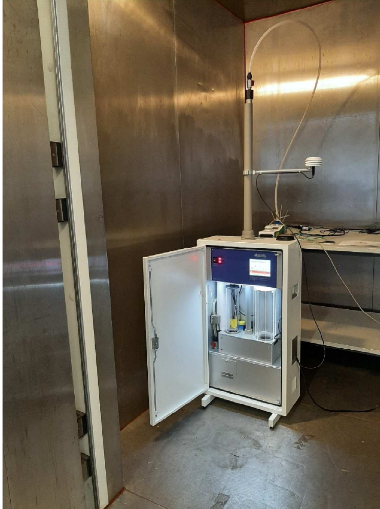
Abbildung 9: Aufbau DPA-14 Standard (mit Kühlung der beaufschlagten Filter) in Klimakammer
