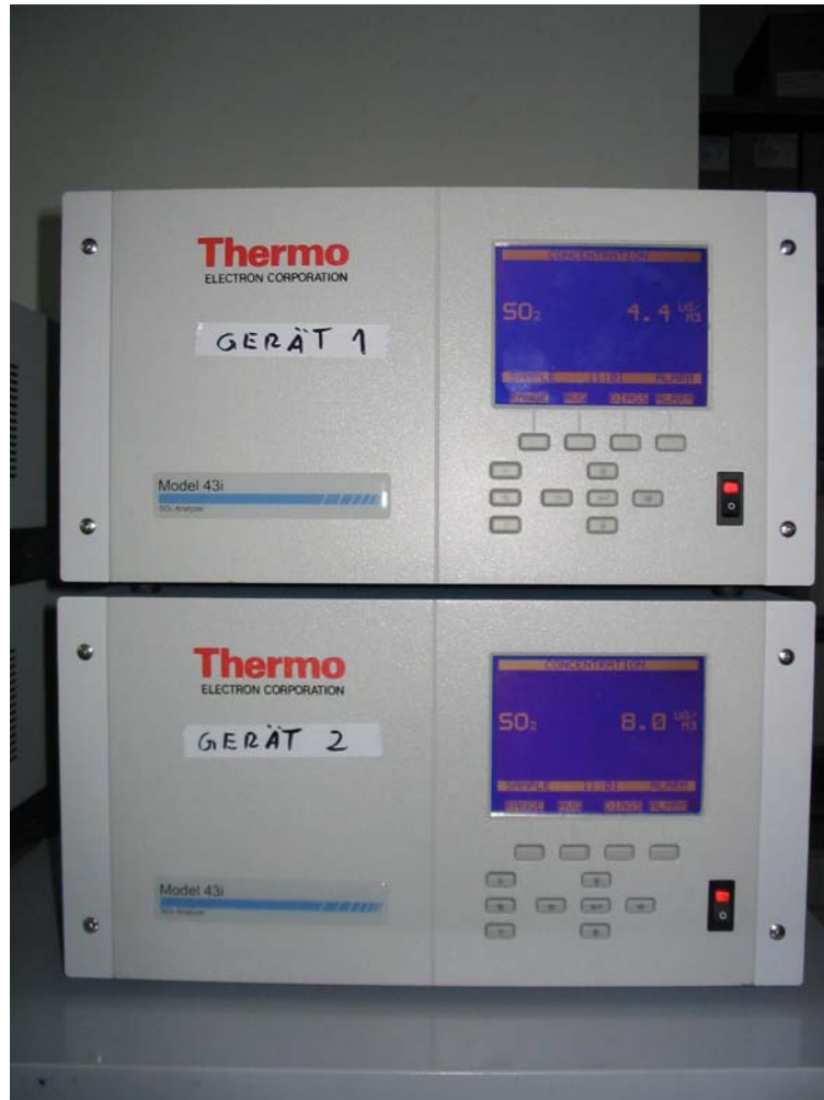
Abbildung 3: Frontaufnahme der im Messcontainer installierten Messeinrichtungen
