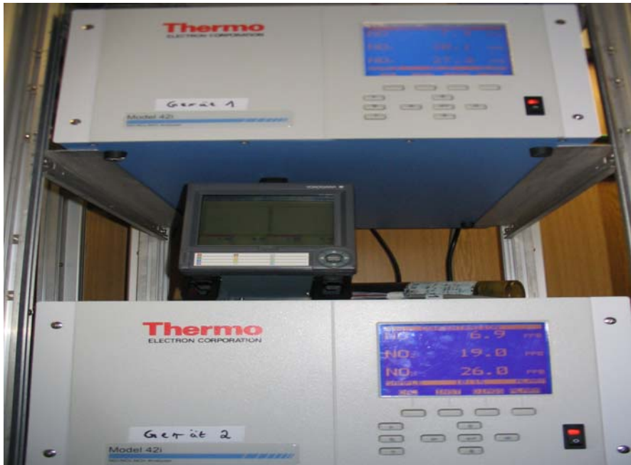
Abbildung 3: Frontaufnahme der im Messcontainer installierten Messeinrichtungen
